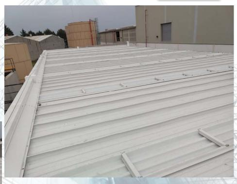
Laminación en cubierta a base de sistema tipo sándwich, lamina base R-101+ aislante rígido AC FOAM II+ Kr-18 con lámina acrílica T-2
